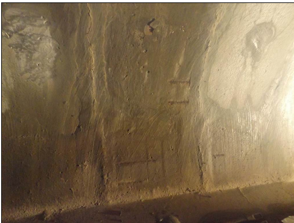
Obr. č. 9 - pohled na železobetonové prefabrikáty ostění s vystupující zkorodovanou výztuží
