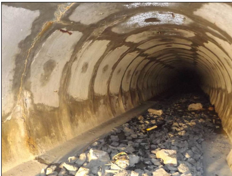
Obr. č. 5 - pohled do objektu zleva v ražené části. Ostění je tvořené z železobetonových prefabrikátů.
