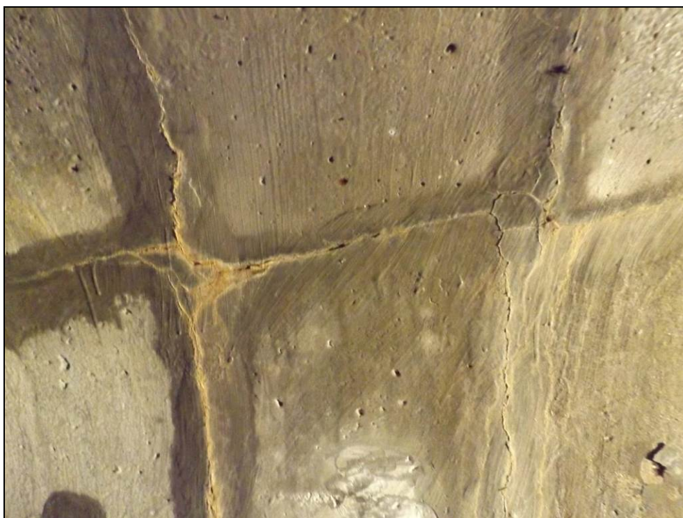
Obr. č. 11 - detailní pohled na ostění, propagace spár mezi železobetonovými prefabrikáty ostění. V místě spár jsou praskliny, skrze které dochází k průsakům vody a usazování výluhů z pojiva
