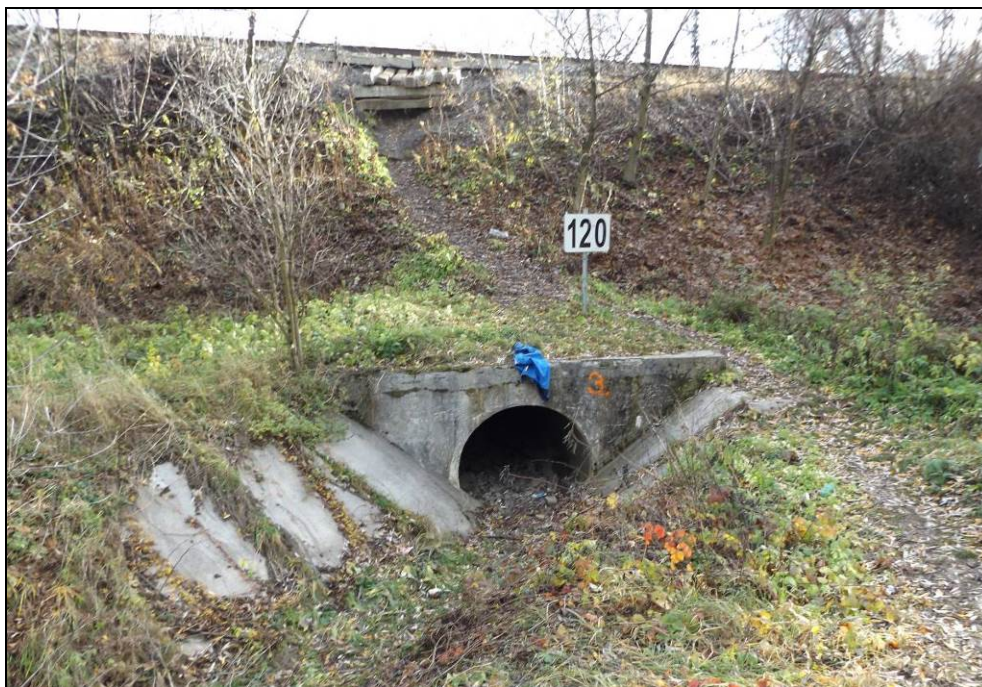
Obr. č. 2 - pohled na levé čelo. Pravé čelo je skryté pod terénem vpravo trati, kde je propustek napojen na kanalizační síť.
