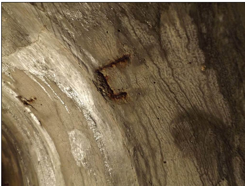
Obr. č. 10 - detailní pohled na železobetonové ostění v místě oprysku krycí výztuže betonu od koroze výztuže
